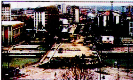
De bestaande brug over de Ibar Internet
